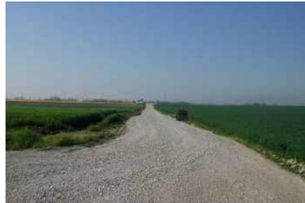
Photo 25 : Exemple de chemin d'accès après renforcement (Source : BE Jacquel et Chatillon)
