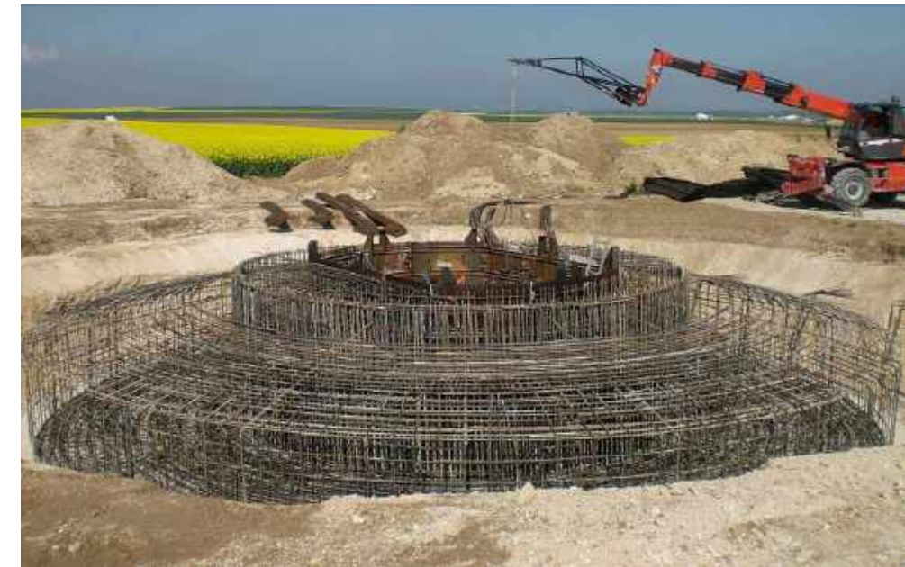
Photo 29 : Exemple de maillage d'acier d'armature pour fondation d'éoliennes de type massif poids (Source : BE Jacquel et Chatillon)
