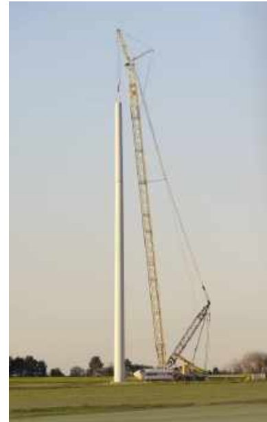
Photo 19 : Assemblage d'un mât d'éolienne (Source : VESTAS)
