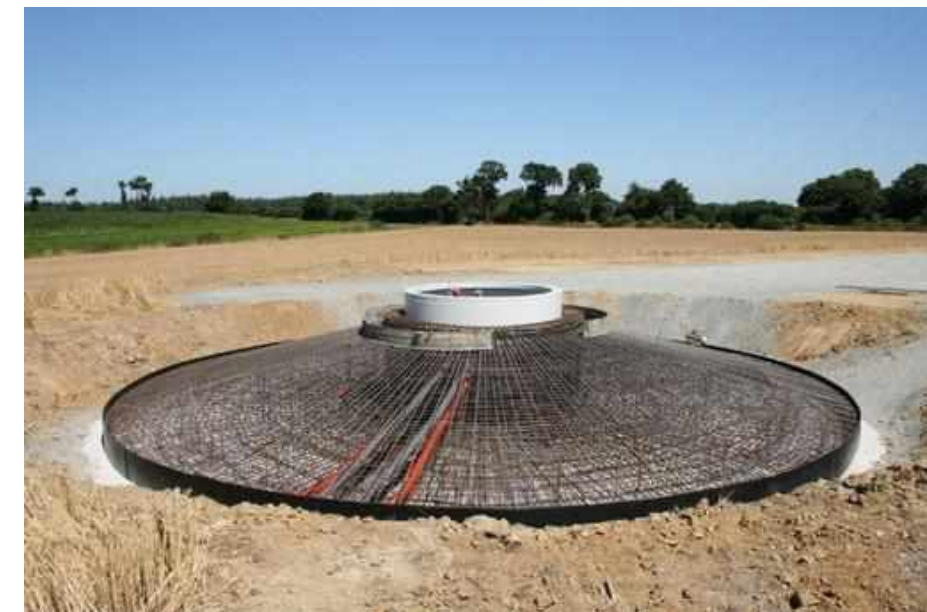
Photo 34 : Exemple d'emprise au sol d'une éolienne (fondations) visible en phase de chantier (Source : VESTAS)
