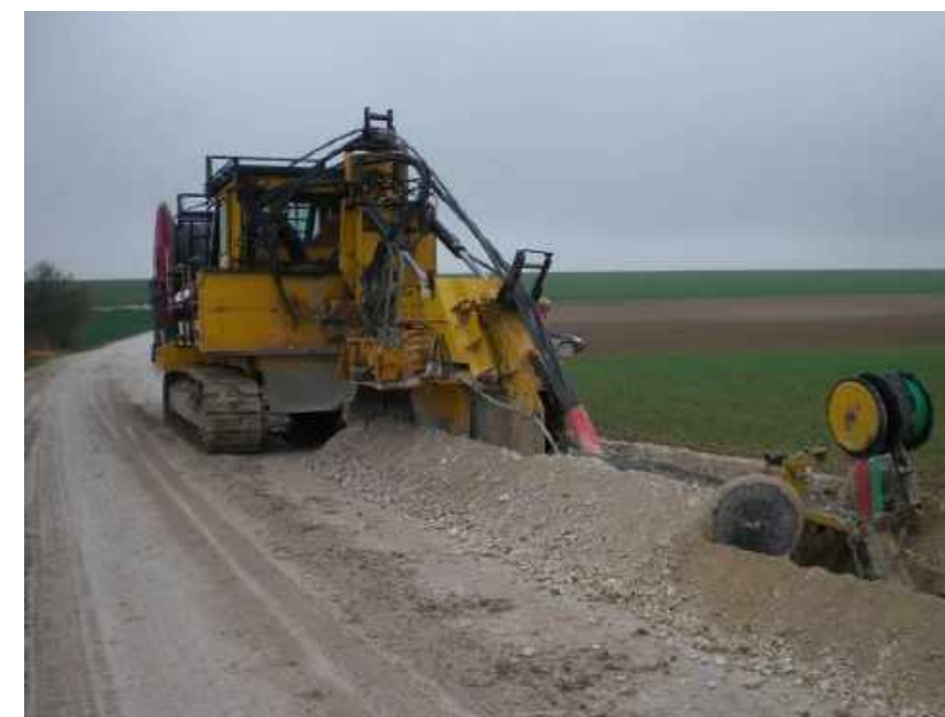
Photo 32 : Pose mécanisée de câbles électriques (Source : BE Jacquel et Chatillon)
