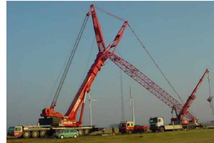
Photo 27 : Grues nécessaires au montage des aérogénérateurs et à l'assemblage des rotors (Source : NOLTE)
