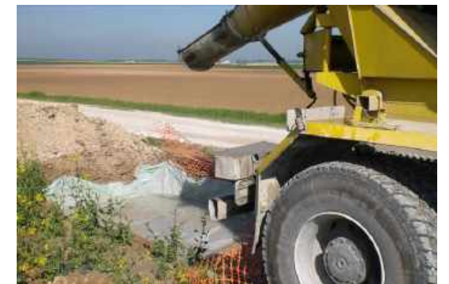
Photo 41 : Exemple de récupération des laitances de béton (Source : BE Jacquel et Chatillon)
