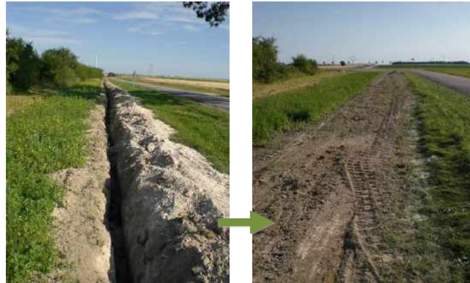
Photo 33 : Rebouchage de tranchée après passage des câbles électriques (Source : BE Jacquel et Chatillon)
