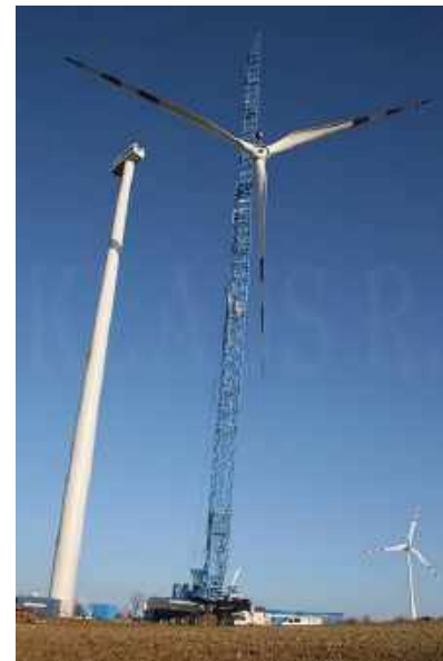
Photo 20 : Exemple de montage d'un rotor d'éolienne (Source : VESTAS)
